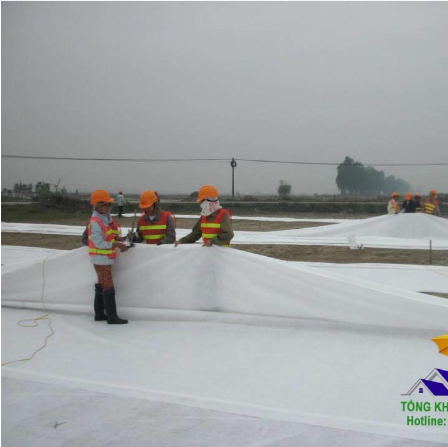
Nối may vải địa
