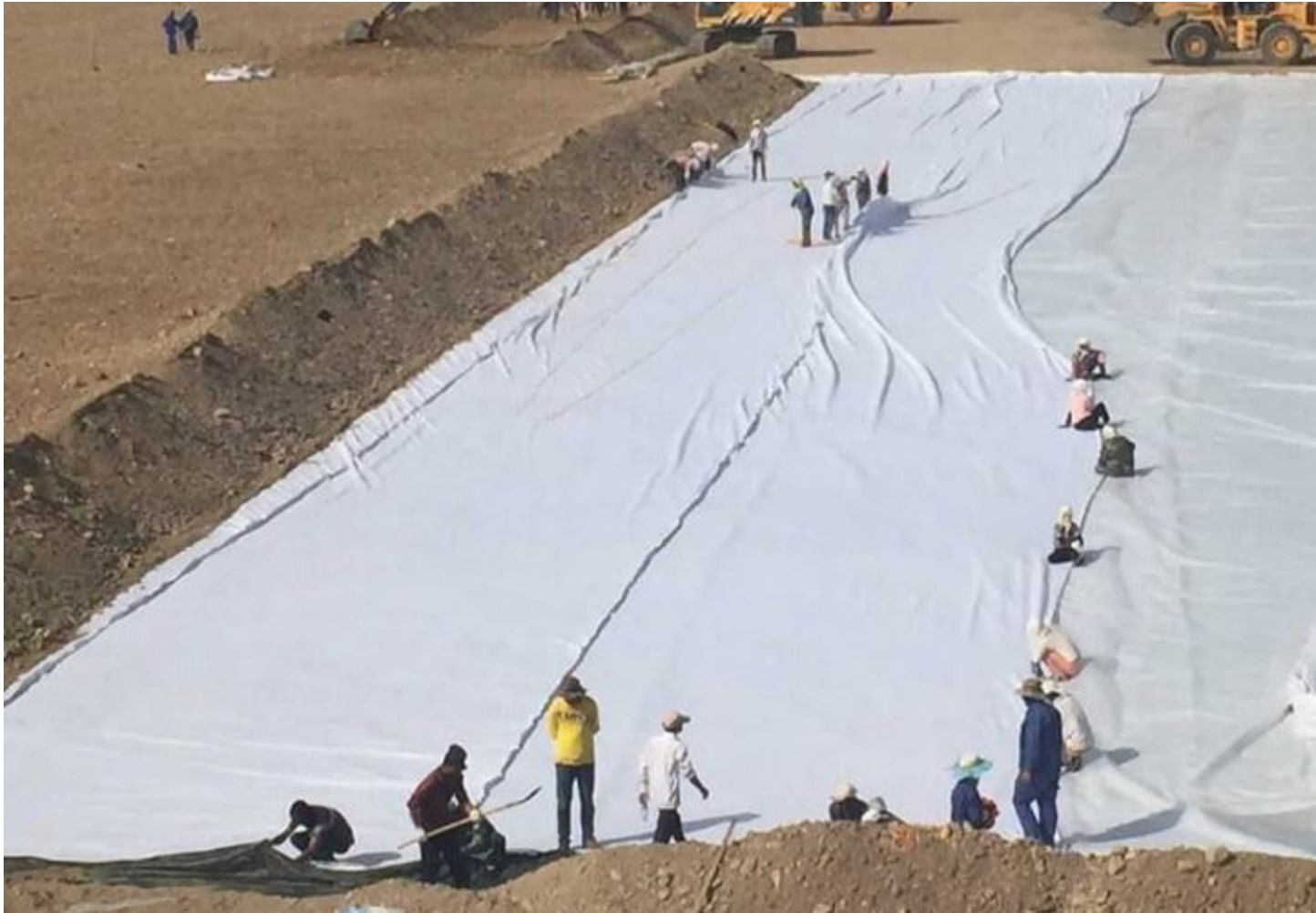
Thi công vải địa kỹ thuật VNT
