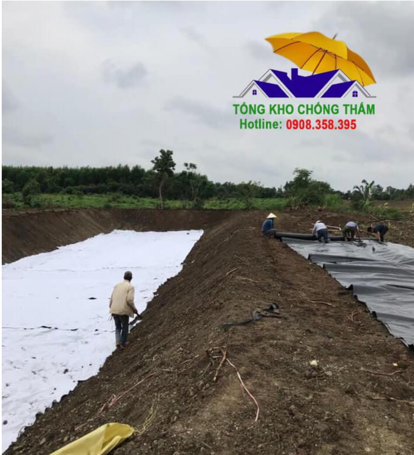
Hạng mục sử dụng vải Biện pháp thi công vải địa kỹ thuật VNT16 không dệt
