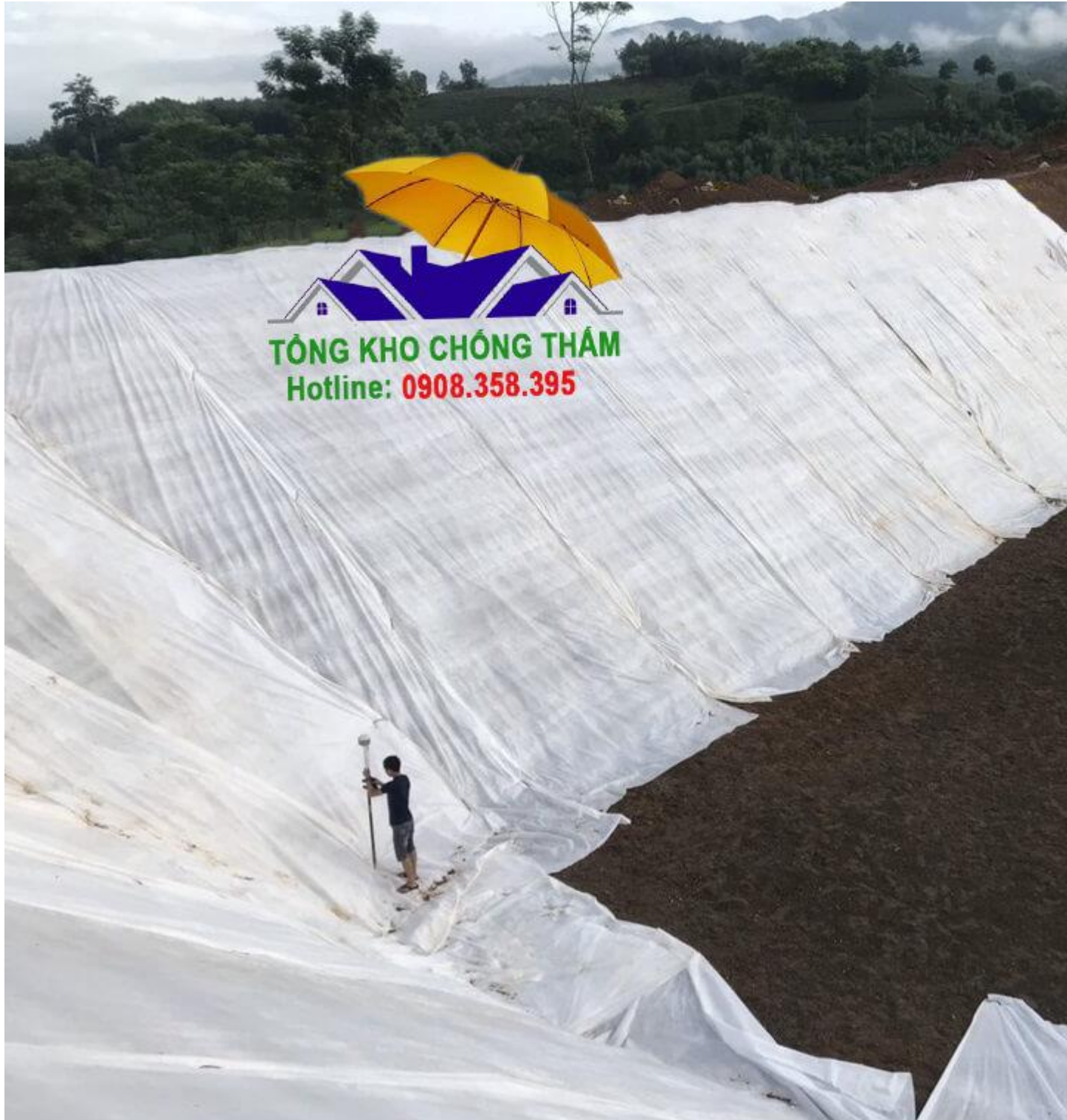
Biện pháp thi công vải địa kỹ thuật
