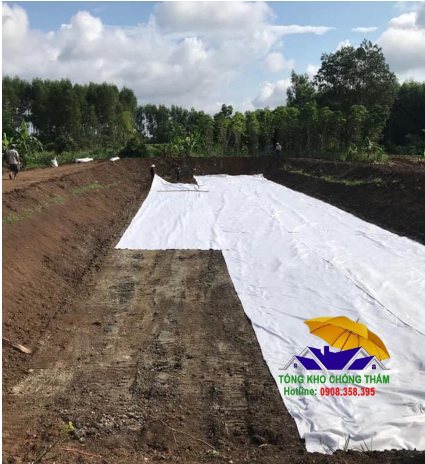
Công tác trải vải
