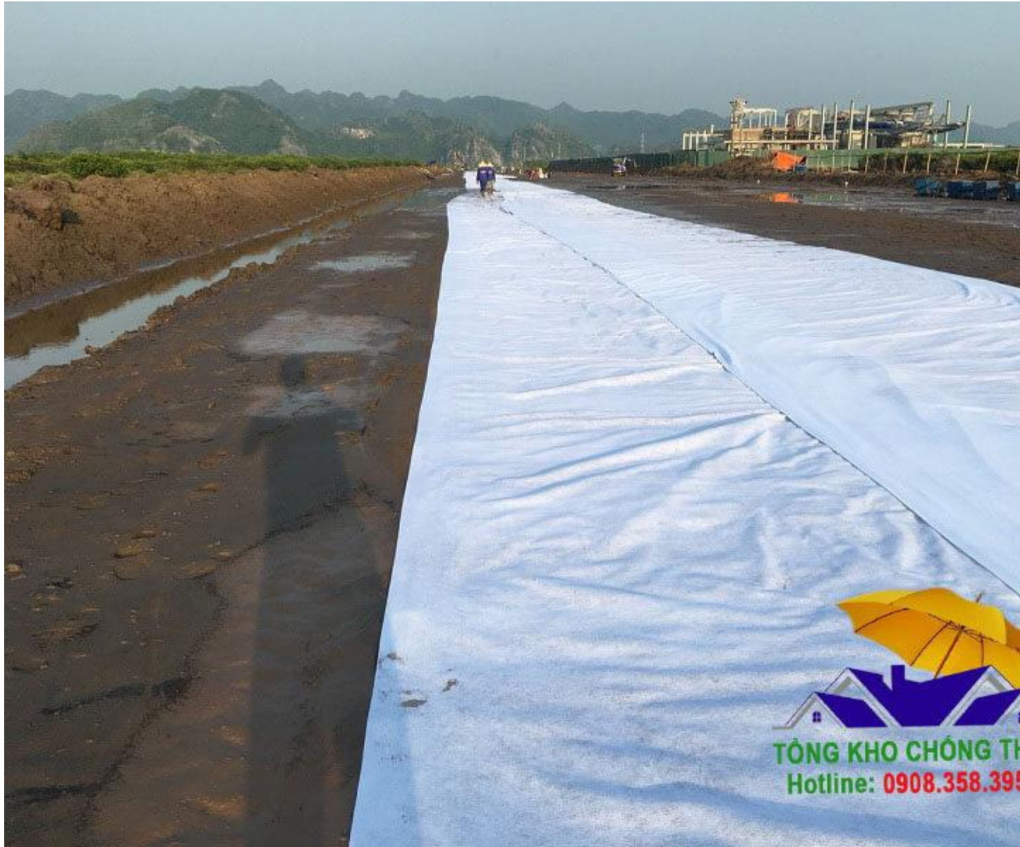
Cách rải vải địa kỹ thuật không dệt
