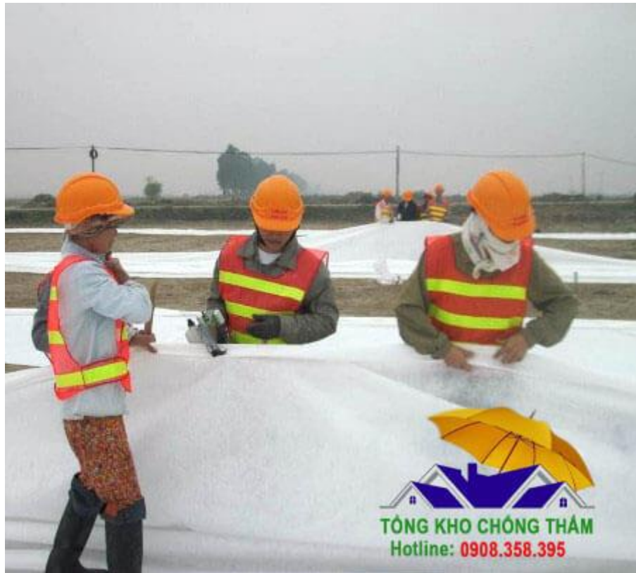
Công tác nối may
