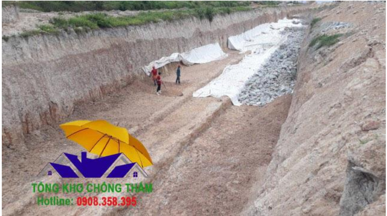
Công tác trải vải
