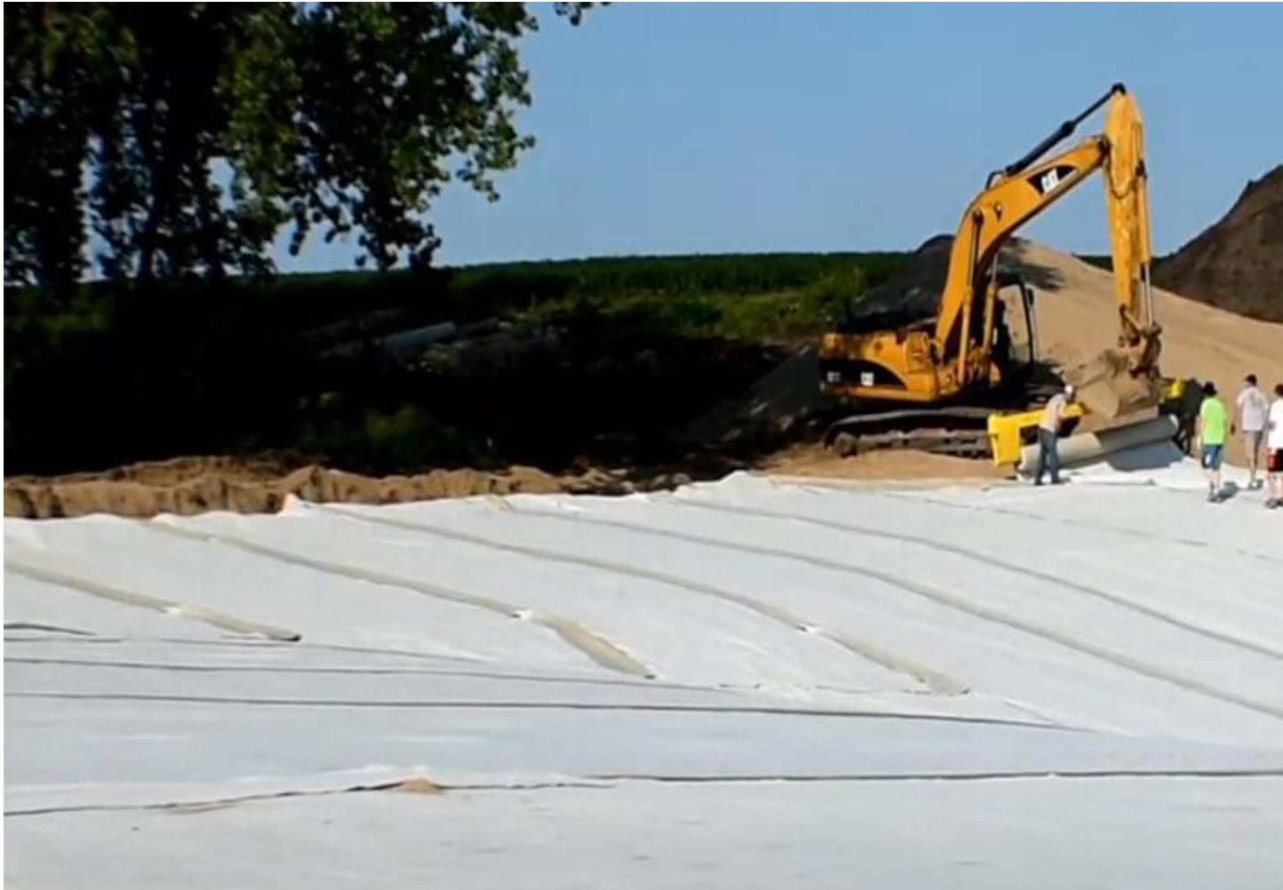
Thi công vải địa VNT
