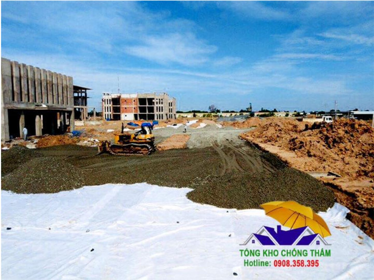
Phương pháp thi công
