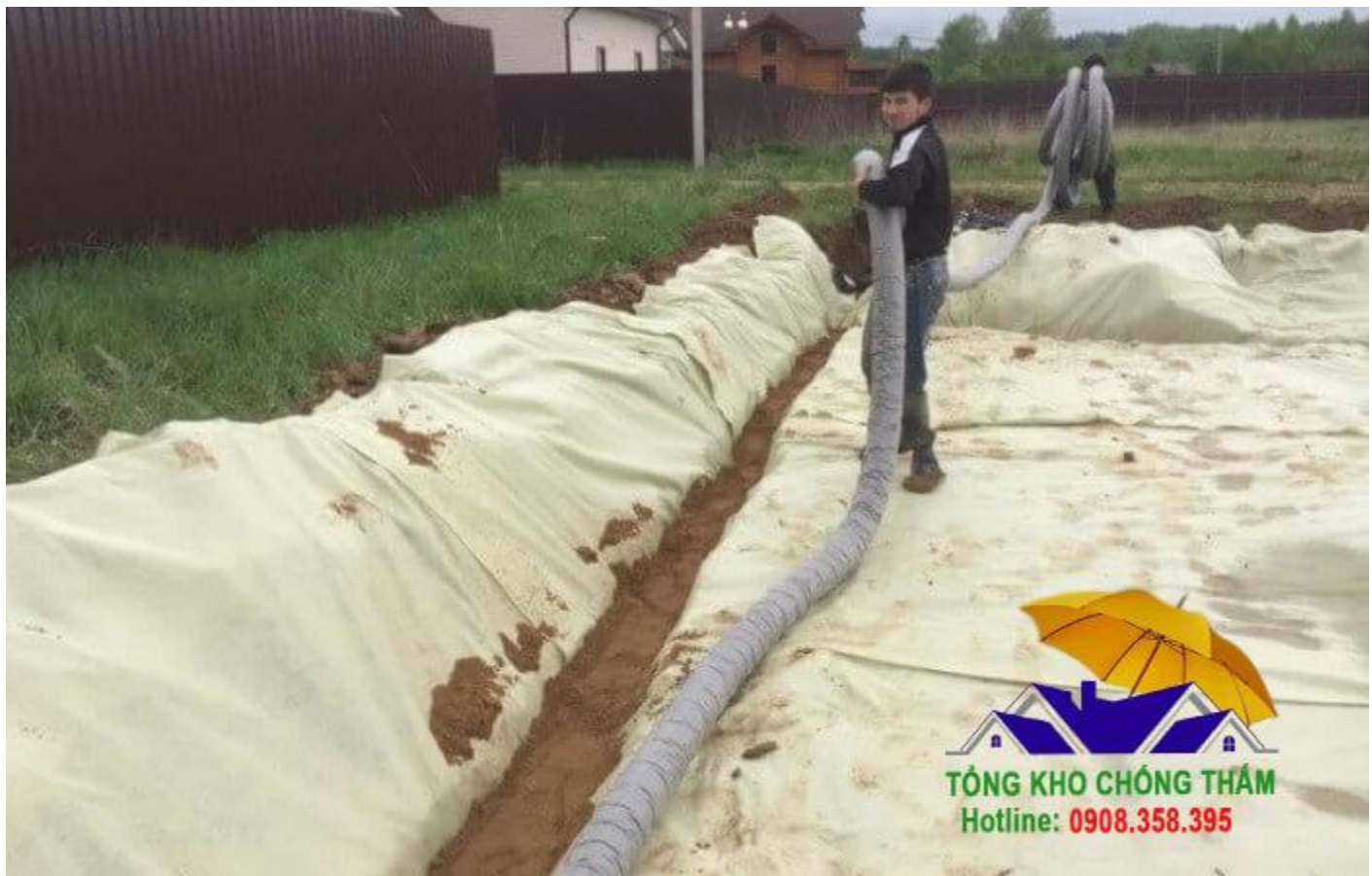
Hình ảnh thực hiện thi công
