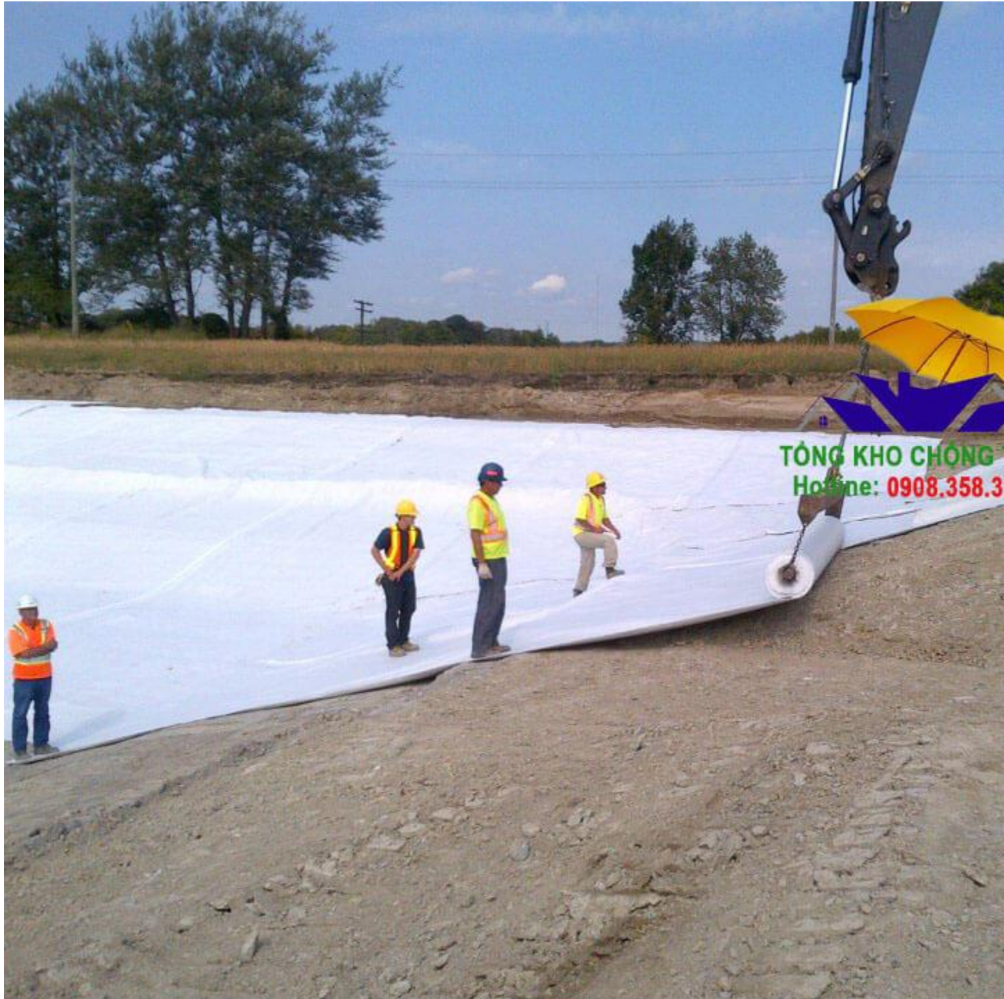
Cách trải vải địa đúng kỹ thuật
