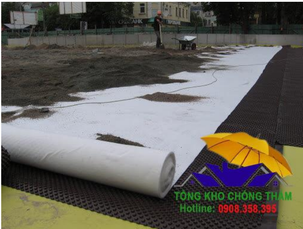
Quy trình thi công
