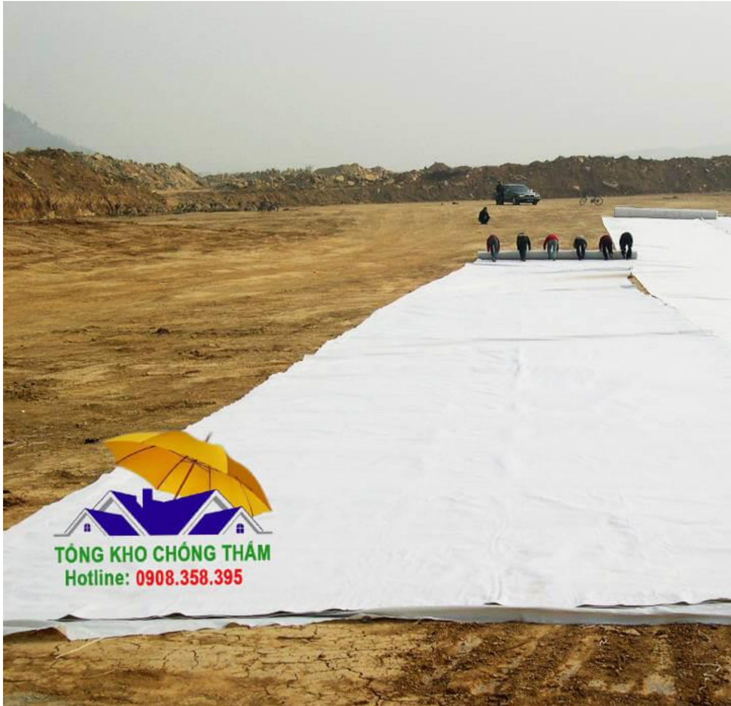
Công tác trải vải
