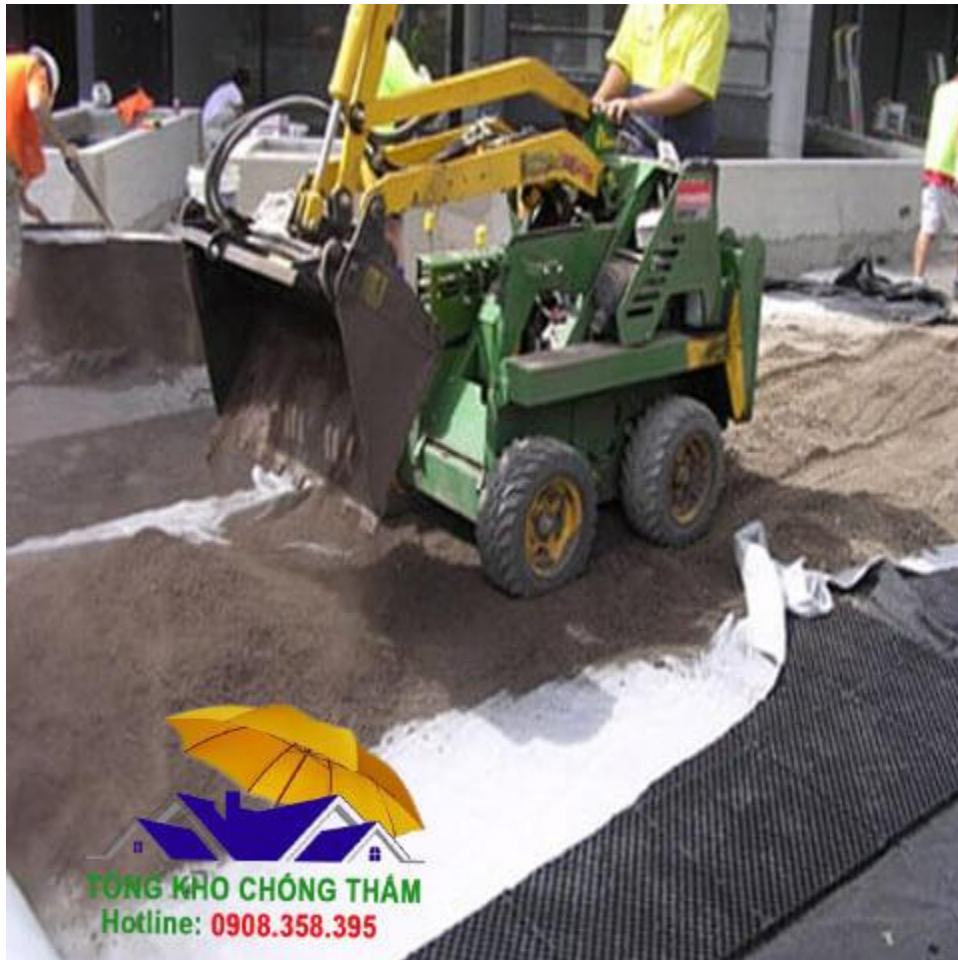
Thực hiện thi công
