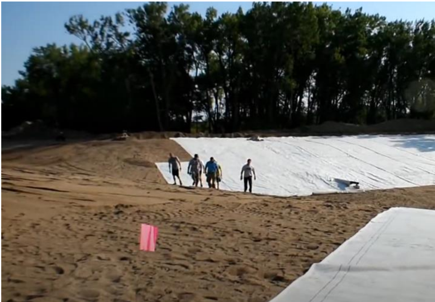
Nối may vải địa
