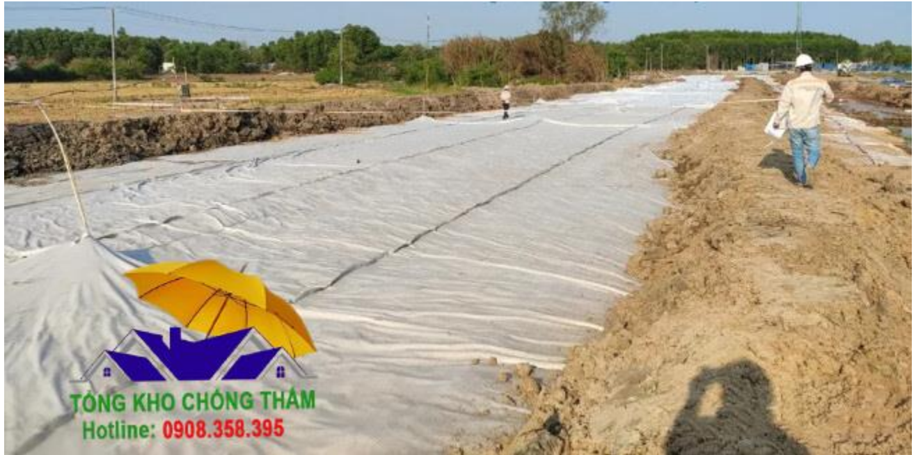
Thực hiện thi công vải
