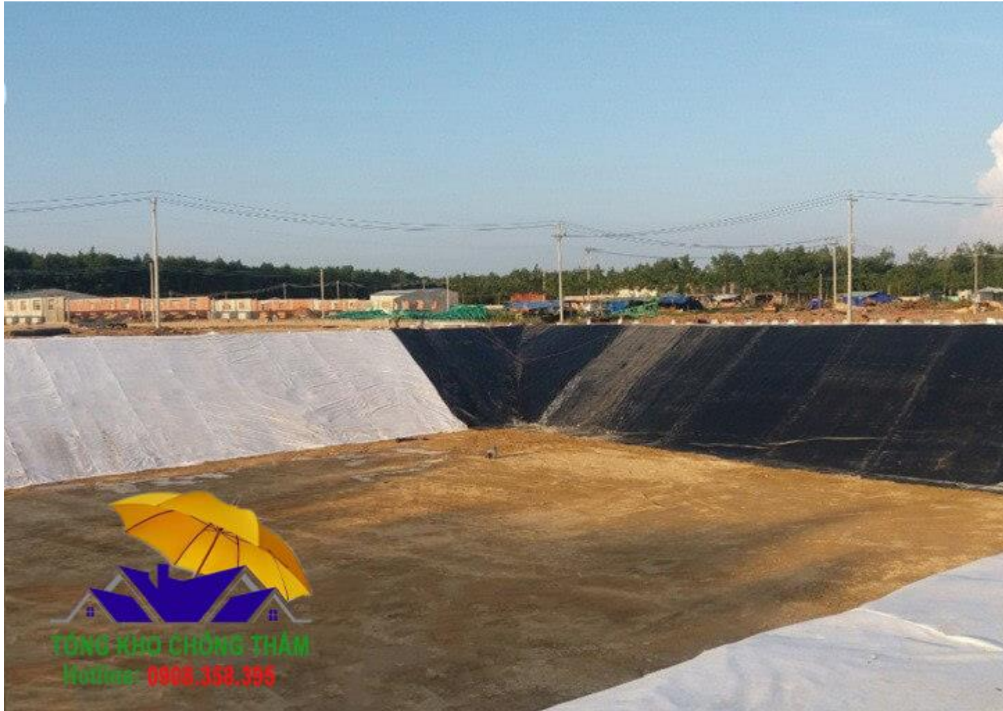
Thi công vải địa VNT
