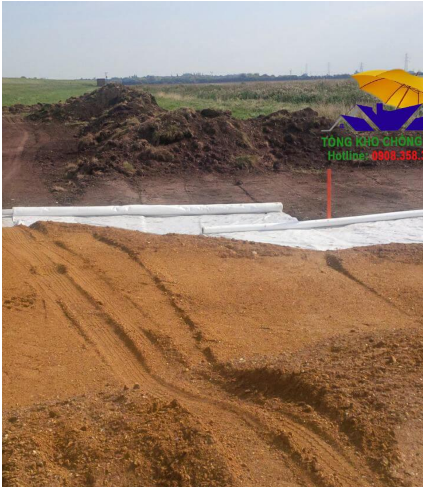
Thực hiện thi công vải địa
