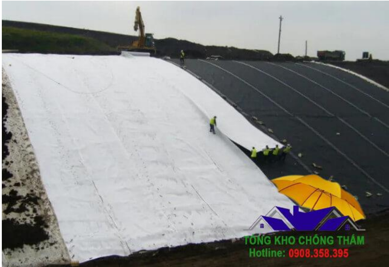
Công tác trải vải
