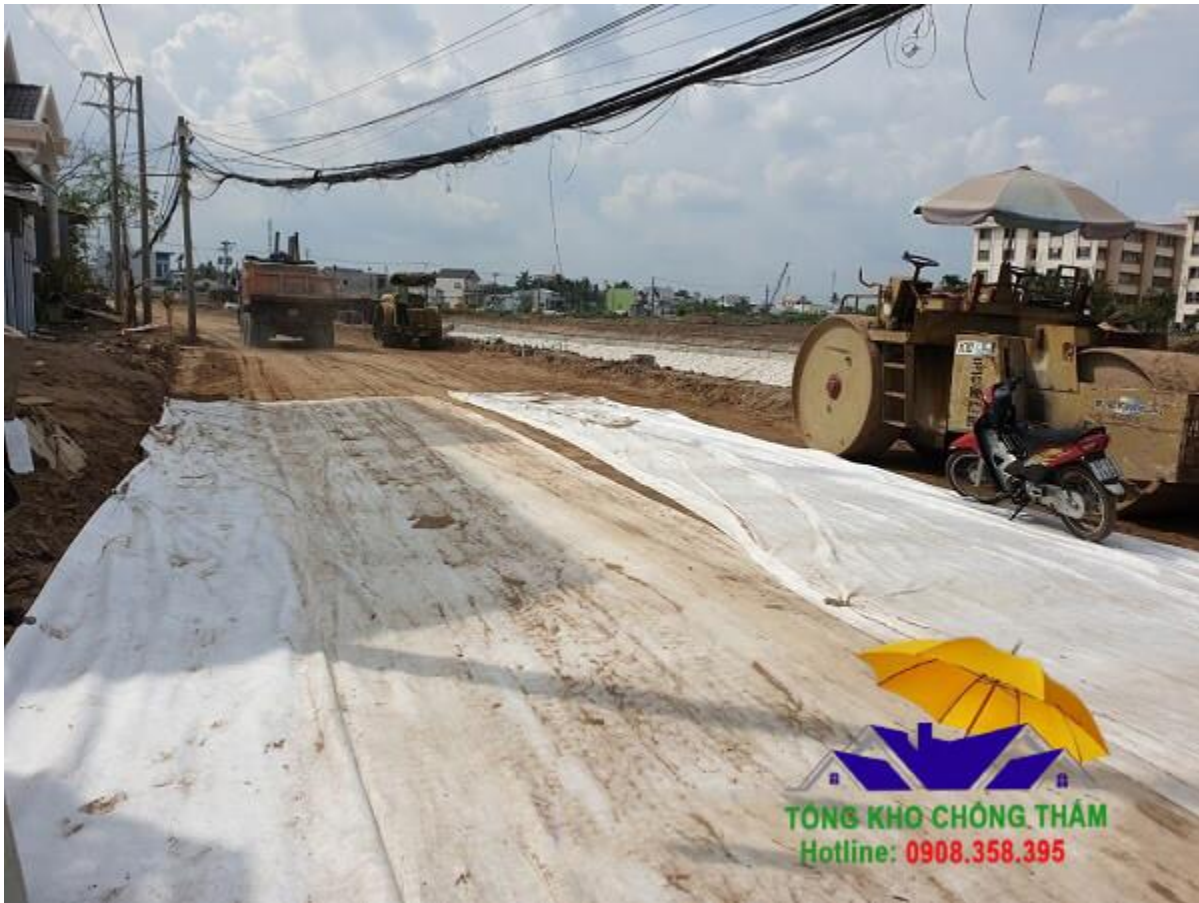
Thi công vải địa kỹ thuật VNT
