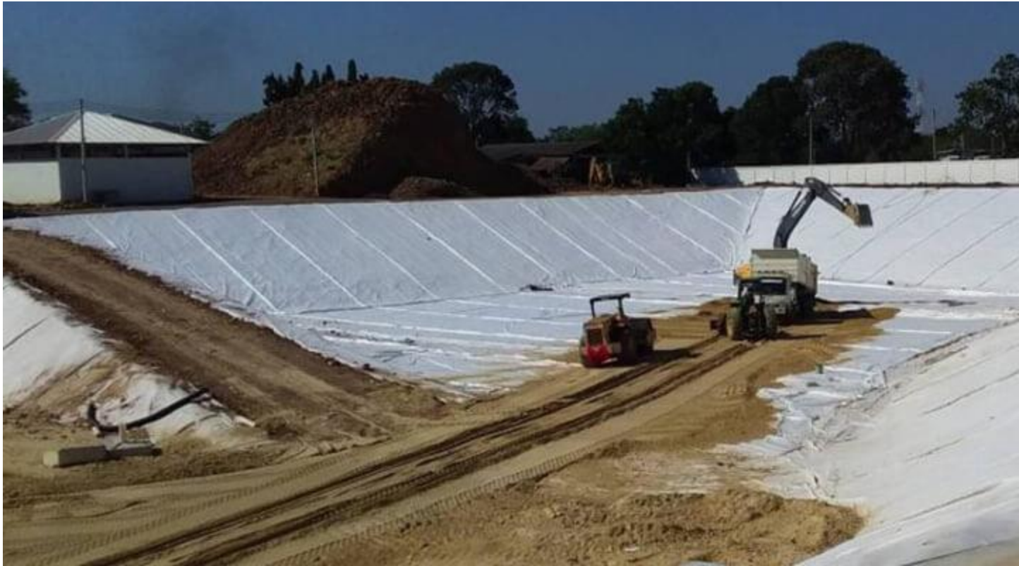
Hình ảnh thi công
