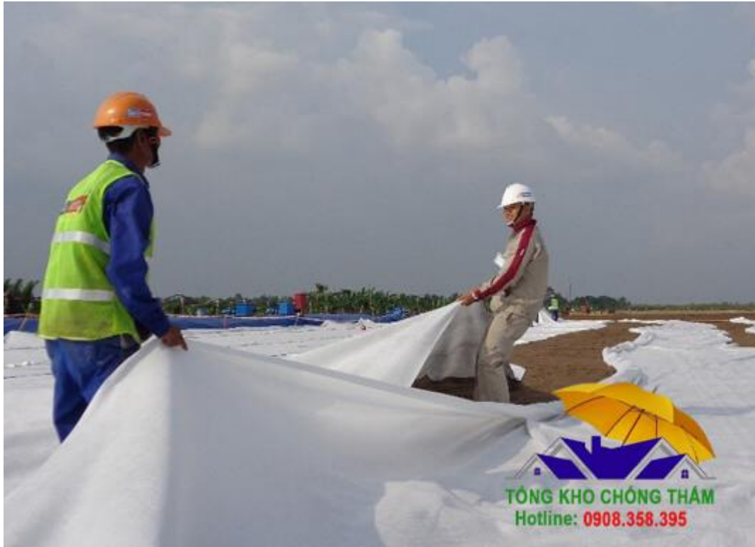
Trải vải địa kỹ thuật
