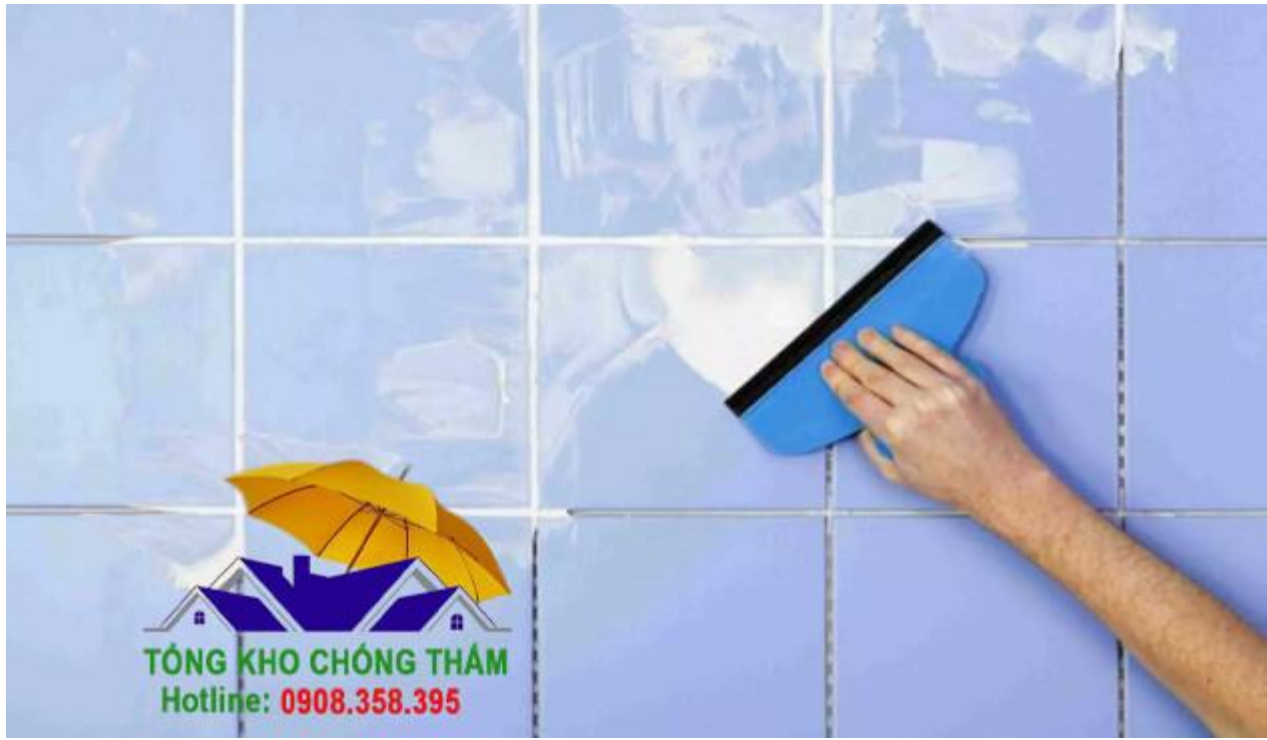
Biện pháp thi công keo chà ron weber
