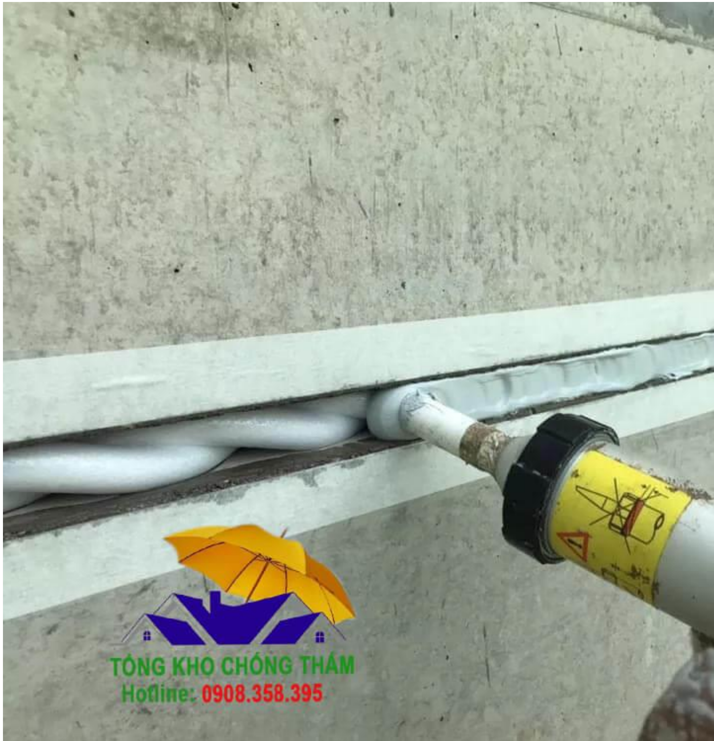
Thực hiện thi công keo trám khe
