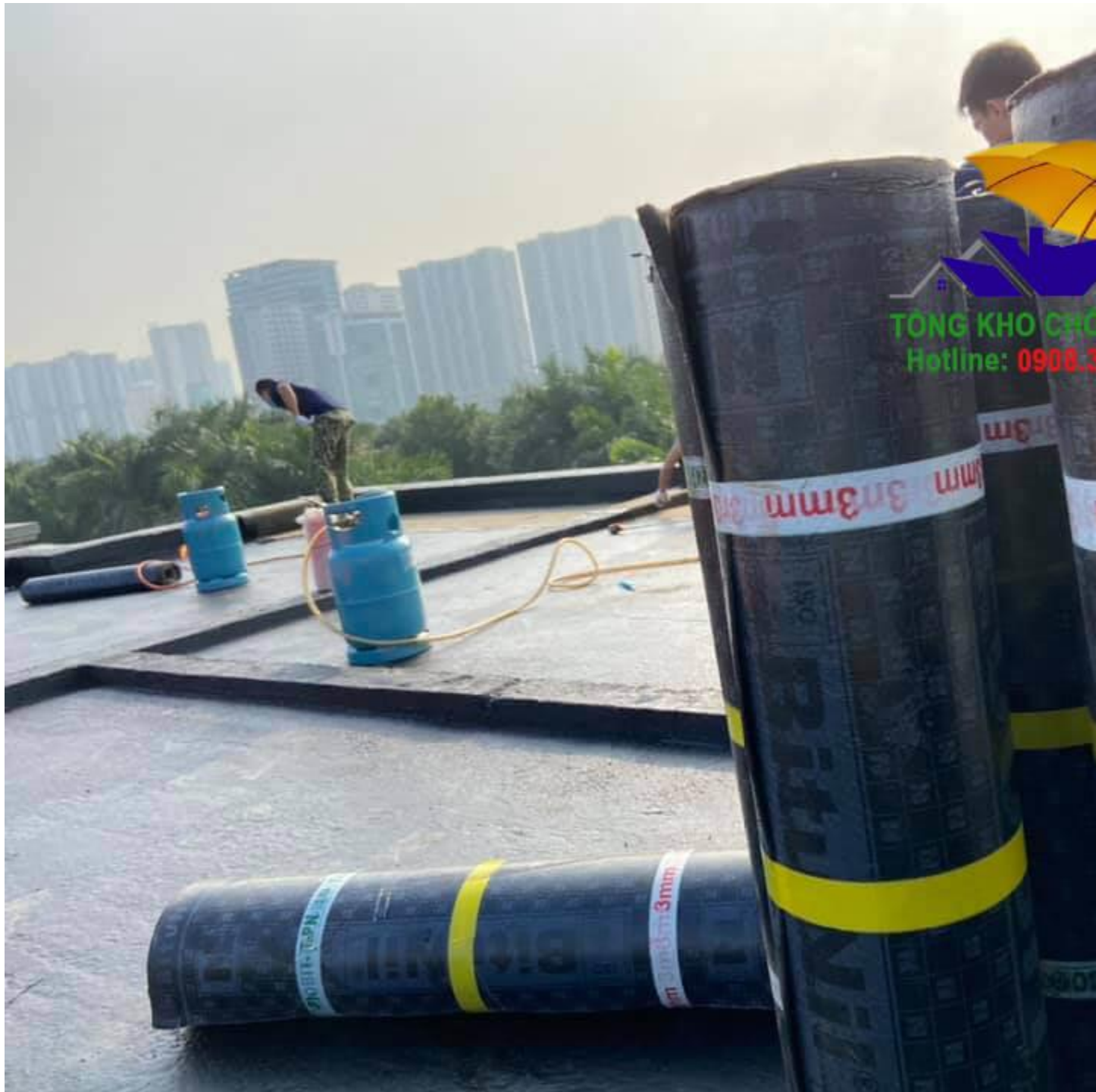
Chống thấm sàn mái
