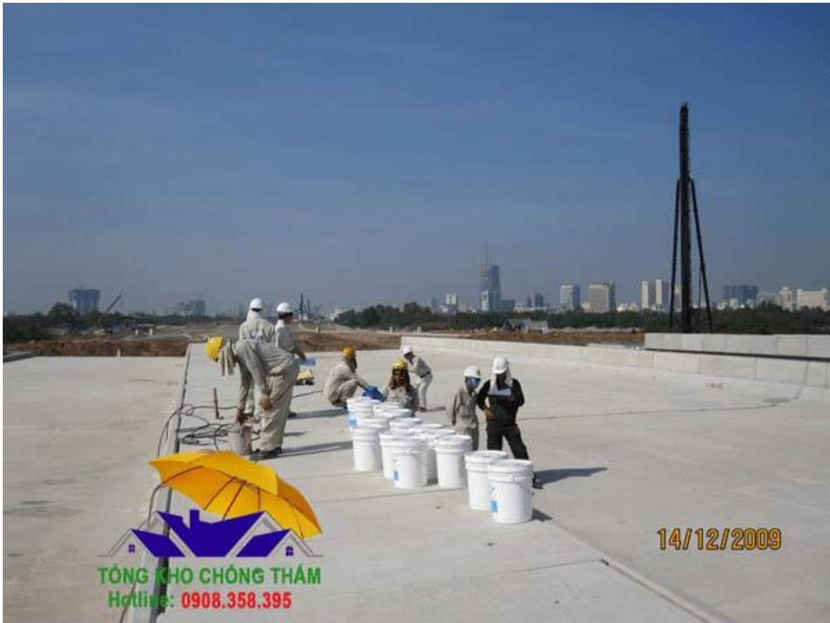
Thi công Crystal Lok chống thấm
