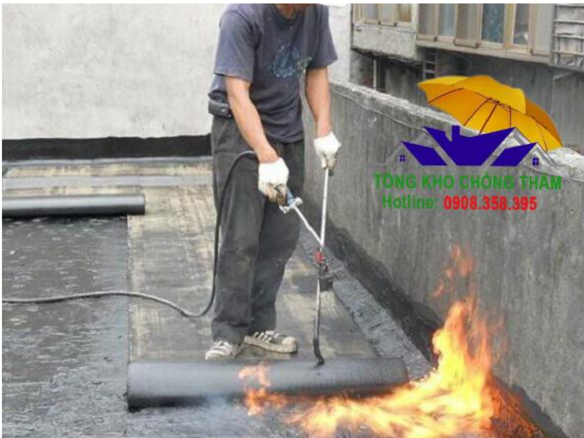
Hình ảnh thi công
