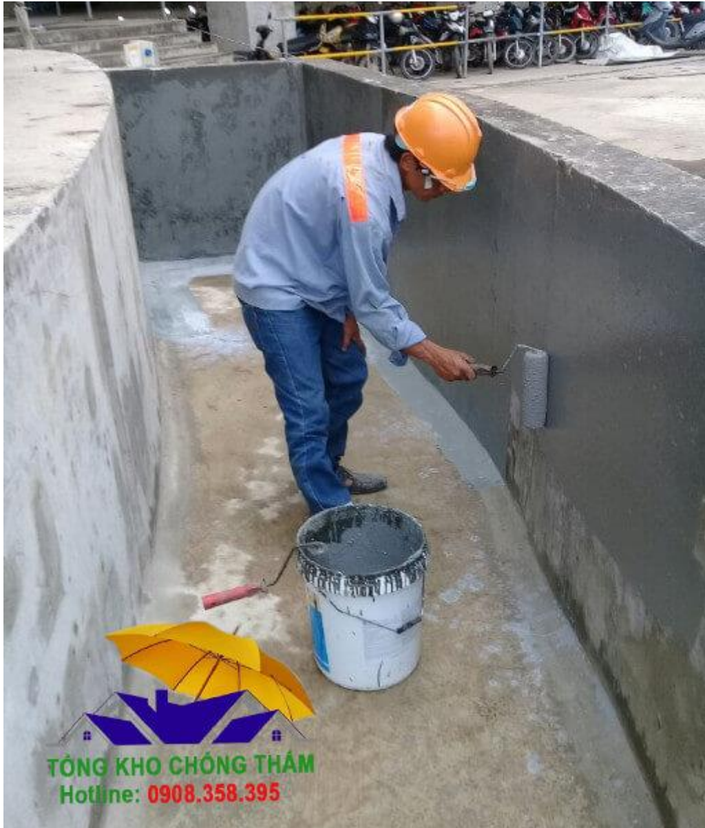
Cách thi công chống thấm 2 thành phần
