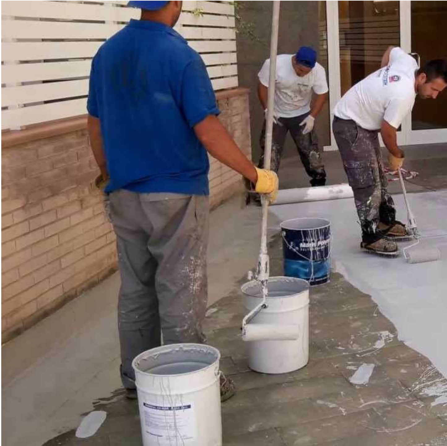
Thực hiện thi công
