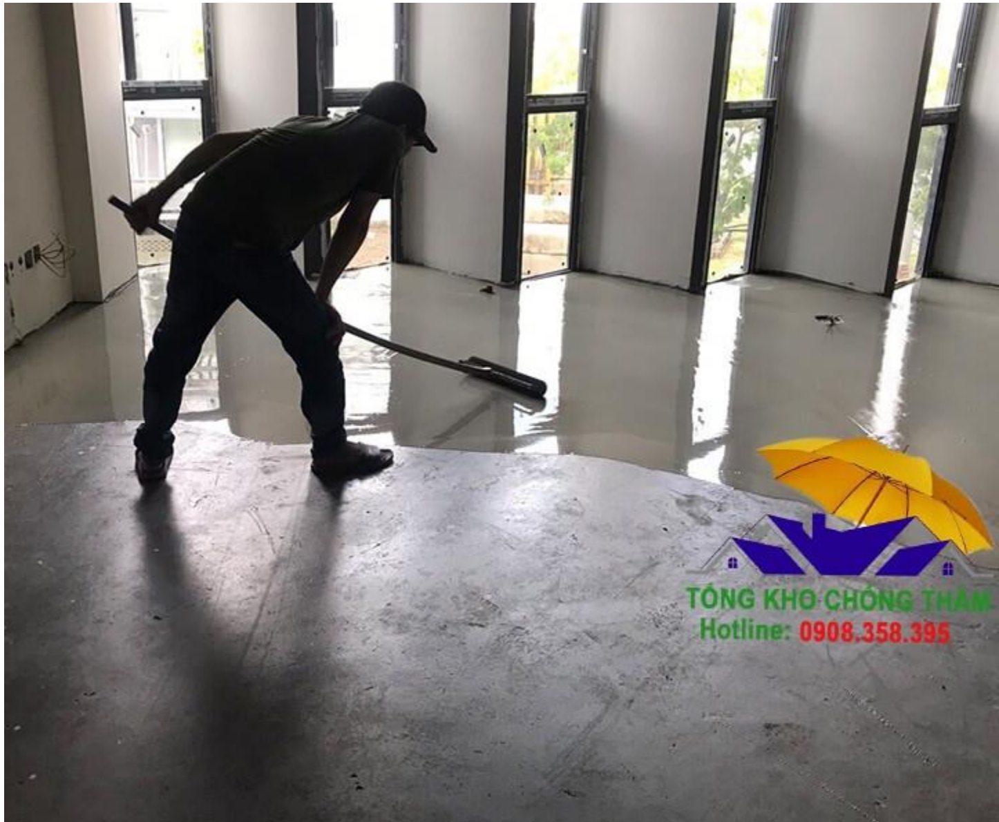
Thi công vữa tự san
