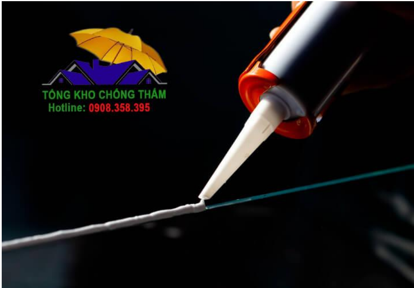
Hình ảnh thi công
