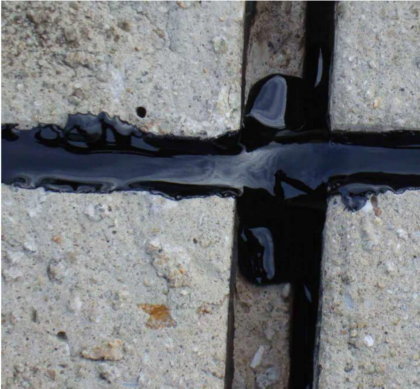
Thi công matit chèn khe
